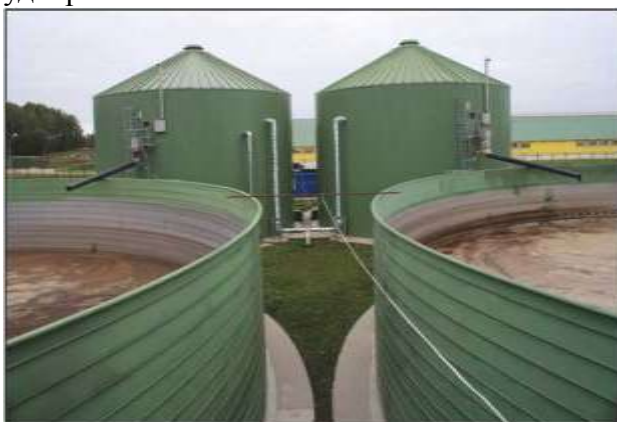
Рис. 4. Резервуары для хранения органического удобрения.
